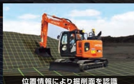
位置情報により掘削面を認識
