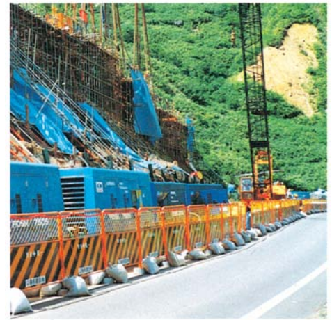
●ダウンザホールドリルのエア源
