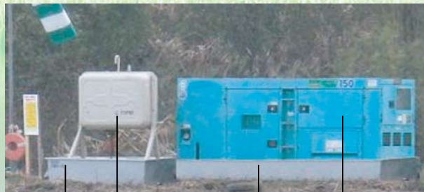
外部燃料タンク 燃料タンク用防油堤 発電機本体 発電機用防油堤
